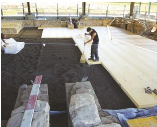
**Fig. 28** – La couche d'argile expansée est couverte à son tour de plaques de mousse isolante d'une épaisseur de 12 cm
