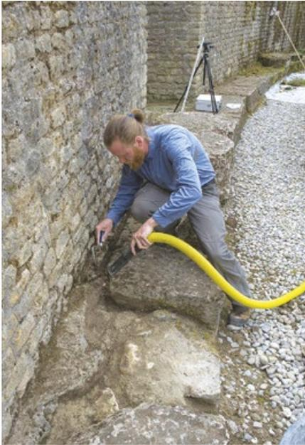
*Fig. 25 – À l'amphithéâtre, Anjo Weichbrodt, conservateur-restaurateur, s'active à éliminer les mousses et les sédiments infiltrés dans le couloir bordant l'arène. Ce travail préliminaire est nécessaire pour pouvoir effectuer de façon efficace le nettoyage à la glace carbonique*
