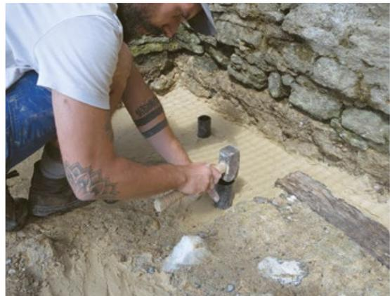
**Fig. 27** – Aux thermes de Perruet, en vue d'éviter de nouveaux dégâts sur le dispositif de chauffage par le sol (hypocauste), les structures antiques en terre cuite sont recouvertes de matériaux de protection provisoire. Slobodan Bigović, conservateur-restaurateur, met en place la première couche de billes d'argile expansée
