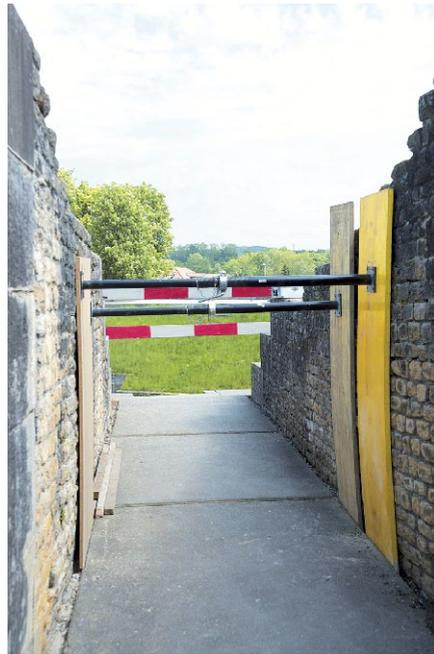
*Fig. 20 – Le renflement des parements de mur dans le vomitoire 8 de l'amphithéâtre a nécessité une intervention urgente. Les parements encore en grande partie intacts ont dû être sécurisés et consolidés de façon à stopper la dégradation des maçonneries et à éviter tout danger d'effondrement pour les visiteurs*
