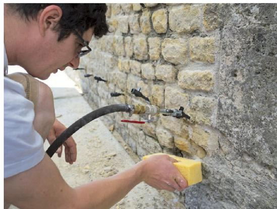
*Fig. 21 – Noé Terrapon, responsable de la conservation-restauration des monuments d'Aventicum, procède à l'injection de mortier de chaux dans une maçonnerie antique*
