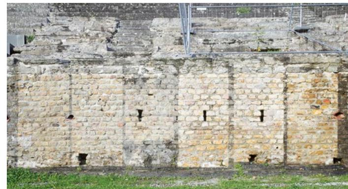
**63** Amphithéâtre. Résultat des différents tests de nettoyage effectués sur le mur de podium nord du monument.
