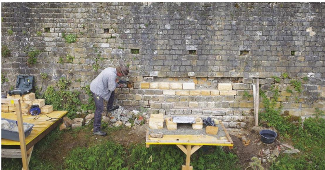
45 Remplacement des moellons de calcaire endommagés du parement de la muraille.
