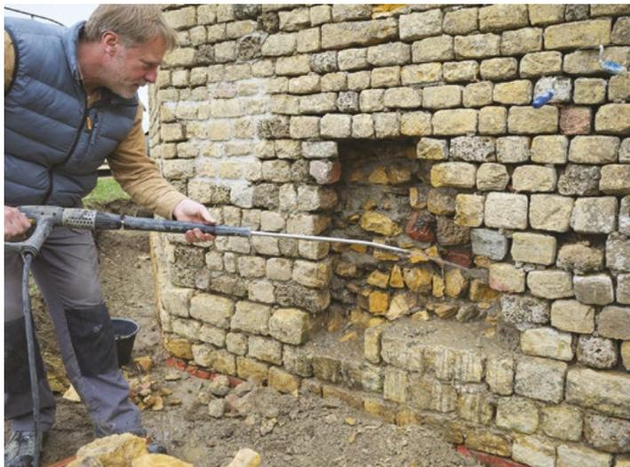
44 Nicolas Staudenmann à l'œuvre sur le parement endommagé du mur d'enceinte. Le noyau du mur est visible dans la lacune du parement.
