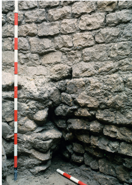
866 Maurrest PO_M8 (links im Bild) an der Fundament-UK von PO_M1 (Ausgrabung 1963.12).
