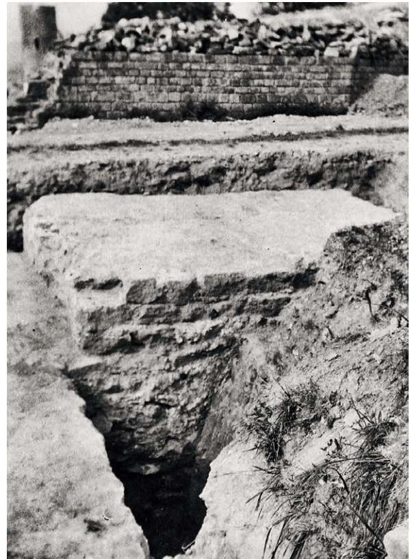
637 PE_M4 (Bildmitte) stösst im Westen an PE_M9 an. Im Hintergrund ist der restaurierte Westteil von PE_M3 zu sehen (1917).
