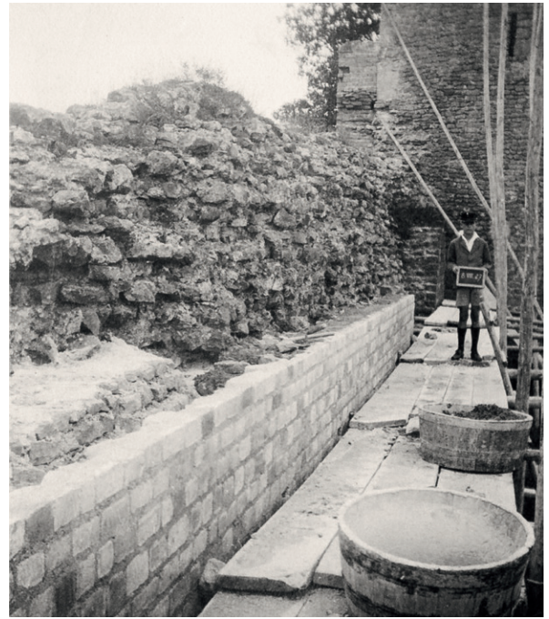
668 Auf dem Baugerüst nördlich von T2. Links im Bild ist der originale Mauerkern der Kurtine (T2–T3_M1) zu sehen, davor ist die Mauerschale aus Handquadern wieder aufgemauert worden. Im Hintergrund ist die Nordfassade von T2 mit anhaftenden Teilen der Kurtine erkennbar (12.8.1927).
