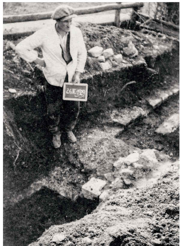
890 Detailaufnahme der gegen Osten von der Kurtine weg-führenden Turmmauer T37_M1 (26.3.1929).
