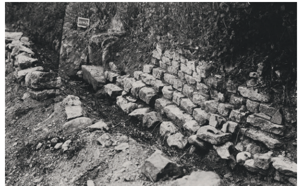
747 Stadtseitiger Abschluss von «aqueduc 1» mit dem abschliessenden Mauerwerk der Kurtine (20.8.1924).
