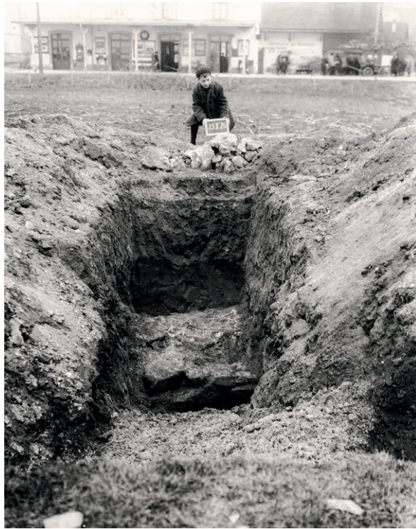
800 Sondierschnitt mit dem südlichen Abschluss der Turmmauer T21_M1 (27.2.1926).
