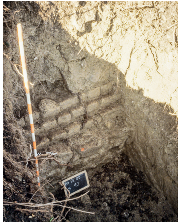
593 Aussenseite der Kurtine (Teilstück T67–T68_M1) mit dem dreifach abgetreppten Fundamentvorsprung am Übergang zwischen Fundament- und Sichtmauerwerk (Ausgrabung 1989.05, Sondage 10).
