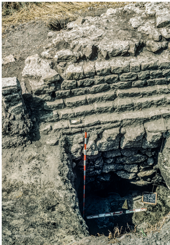
713 Blick auf die Innenseite der Kurtine (Teilstück T11–T12_M1) mit erhaltenem Fundamentvorsprung und maximal drei Lagen an Sichtmauerwerk. An der UK des gemauerten Fundamentes ist im Bereich stehenden Grundwassers der Beginn der Fundamentpfählung zu erkennen (Ausgrabung 1983.02).
