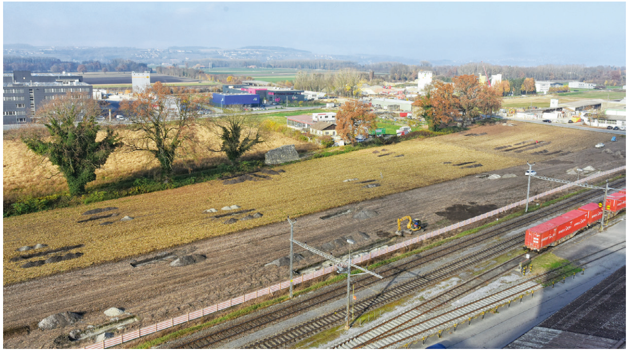
752 Übersicht über die 2015 sondierten Bereiche unmittelbar südlich der Stadtmauer (Ausgrabung 2015.07).
