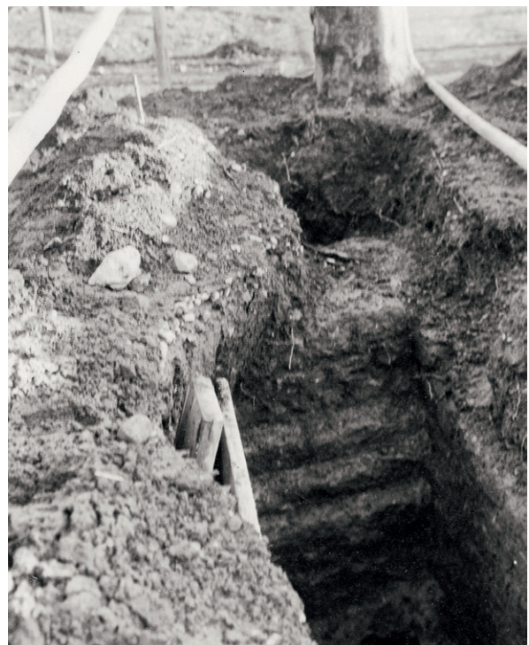
840 Schrägaufsicht auf die Aussenseite der Turmmauer T30_M1 mit dem dreifach abgetreppten Fundamentvorsprung und dem erhaltenen Ansatz des Sichtmauerwerkes (1927).
