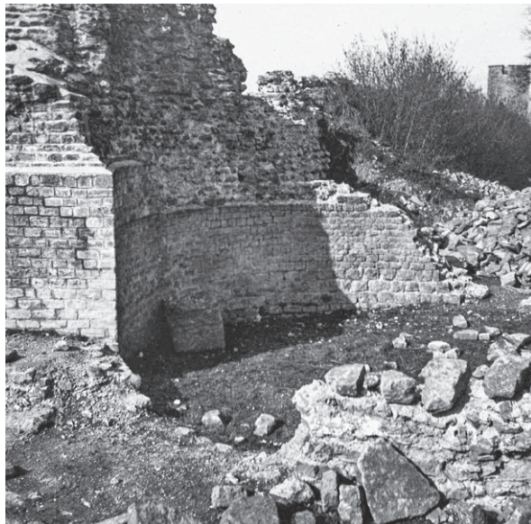
646 Erhaltenes Kleinquadermauerwerk von PE_M11. Deutlich ist der gegen das Turminnere hin rund gestaltete Grundriss zu erkennen (1903).
