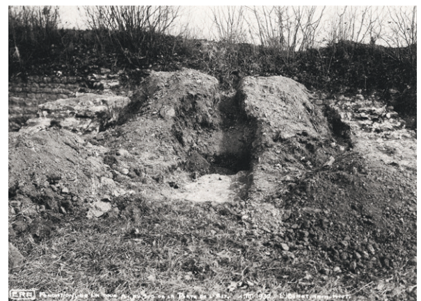
629 Ausgrabung von T73 im März 1932. In der Bildmitte das mutmassliche Mörtelbett der Schwellenkonstruktion von T73 (1.3.1932).
