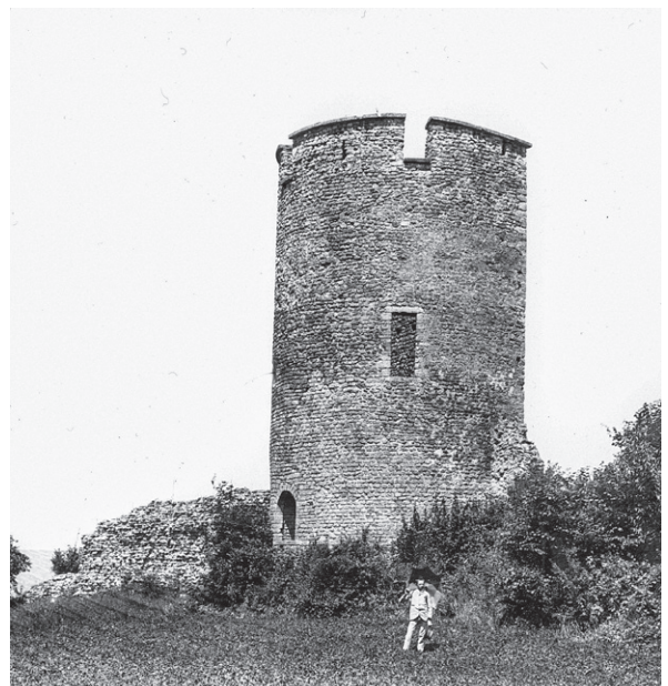
650 T2 vor den umfassenden Restaurierungen des frühen 19. Jh. Die antike Turmmauer T2_M1 reicht bis knapp unterhalb des grossen Fensters an der Südseite und ist anhand des deutlich homogenen Mauerwerks zu erkennen (ca. 1898).
