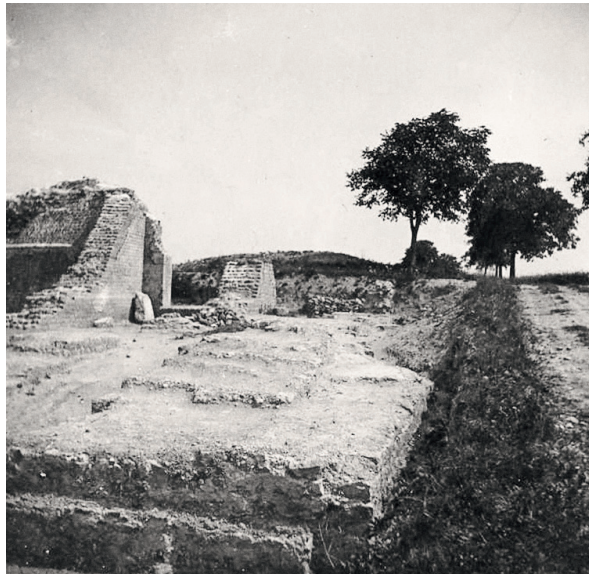
636 Blick von Westen auf PE_M3. Am rechten Bildrand ist die halbrunde Einbuchtung des Innenhofes erkennbar. An der OK der Mauer deuten sich deutliche Negative von grossen Steinquadern an (ca. 1899).
