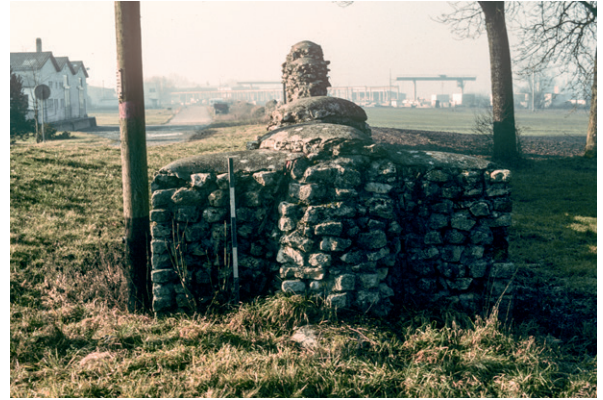
698 Blick auf das östliche Ende der 1902 restaurierten Mauerpartie von La Maladaire (T8–T9_M1). Zustand nach Reinigungs- und Restaurierungsarbeiten in den frühen 1970er Jahren. Im Hintergrund ist die im Aufbau befindliche Industriezone von Avenches erkennbar.
