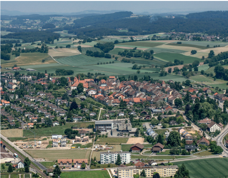
824 Blick auf den westlichen Abschluss der mittelalterlichen Altstadt von Avenches mit der modernen Überbauungsstruktur im Vordergrund. Abschnitt T VI führt in gerader Linie dem Abschluss der mittelalterlichen Stadt entlang in Richtung des ehemaligen Stadtttores (Porte de Payerne) (2006).
