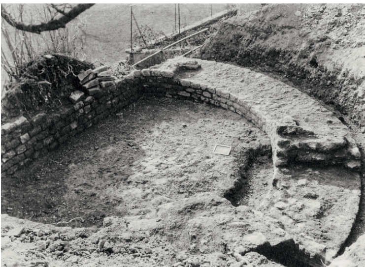
888 Nordöstlicher Teil von T36. Die Turmmauer T36_M1 spart an der Ostseite ein trapezförmiges Negativ, mutmasslich für einen Schwellenstein aus (26.3.1929).
