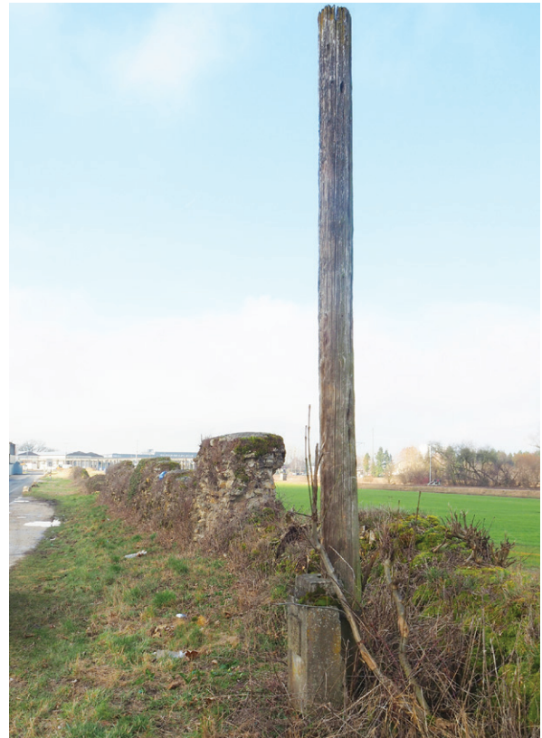
730 Standort von T9 mit dem 1922 angebrachten Betonsockel und Holzpfehl zur Markierung des Turmstandortes. Rechts im Bild der stark überwachsene und einsturzgefährdete Mauerkern (Teilstück T9–T10_M1) (Zustand 2018).
