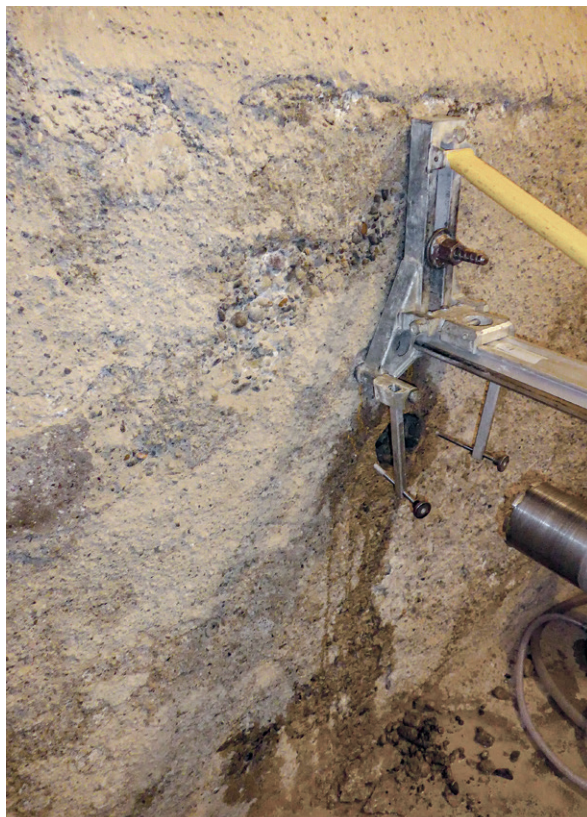
987 Ca. 1890 erstellte 60 cm dicke Kellerwand aus Beton in Winterthur.
