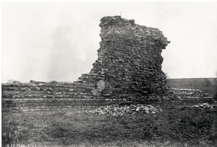
602 Mauerinnenseite der Kurtine im Bereich des Teilstückes T73-PE_M1 («dent») vor den Restaurierungen und Wiederaufbauten ab 1916 (1.4.1916).
