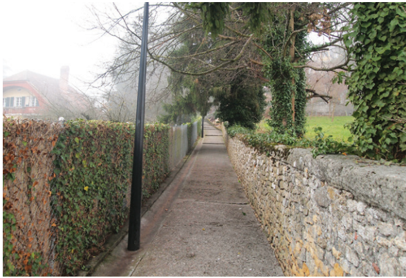
846 Blick in den Chemin du Montmezard von Süden aus. Der neuzeitlich-moderne Weg verläuft auf der Kurtine (Teilstück T31-T32_M1), seitlich wird er von zwei Mauern gerahmt, die auf die Kurtine aufgesetzt wurden (2015).
