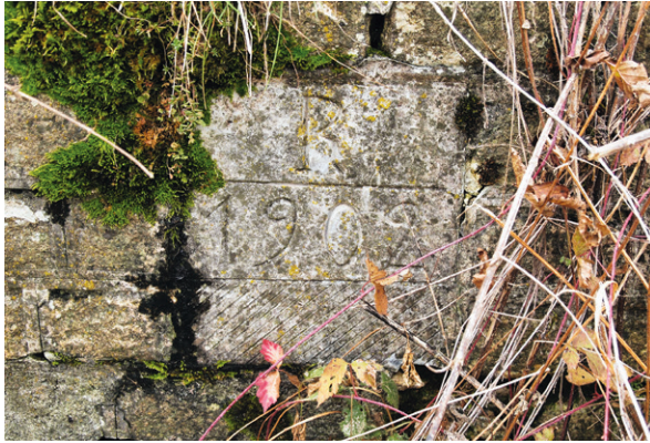
699 Zementplakette mit Inschrift «R 1902» zur Datierung der Restaurierung des Abschnittes von La Maladaire (2015).
