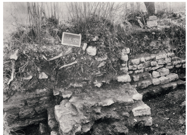
907 Im Vordergrund der kurtinenseitige Abschluss der Turmmauer T54_M1, die hier mit einem abgetreppten Fundamentvorsprung an der Maueraussenseite direkt in jenen der Kurtineninnenseite einbindet (26.3.1929).
