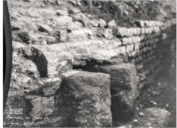
596 Stadtseitiger Abschluss des Leitungsdurchlasses auf Teilstück T71–T72_M1. Hochkant gestellte Muschelsandsteinplatten und eine darüber gelegte Muschelsandsteinplatte als Deckplatte (24.3.1933).
