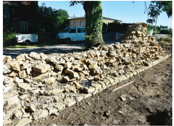
751 Teilstück PN–T17_M1 (Mauerinnenseite) obertägig erhaltenem Mauerkern und dem intakten Ansatz des Fundamentvorsprungs (Restaurierung 2016.12).
