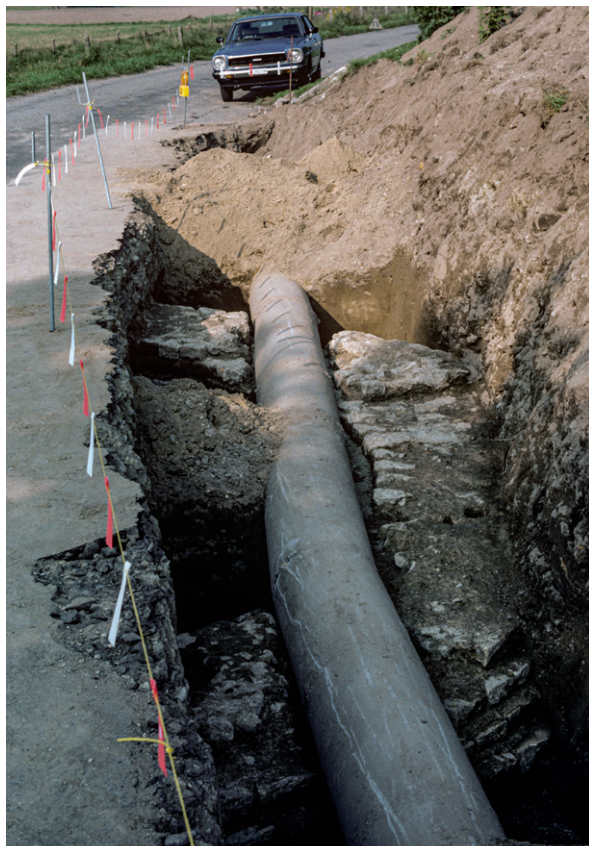
810 T26 mit der, den Turmgrundriss mittig querenden, modernen Betonleitung. Am linken Bildrand verläuft die aktuelle Route de Sous-Ville (Ausgrabung 1982.08).
