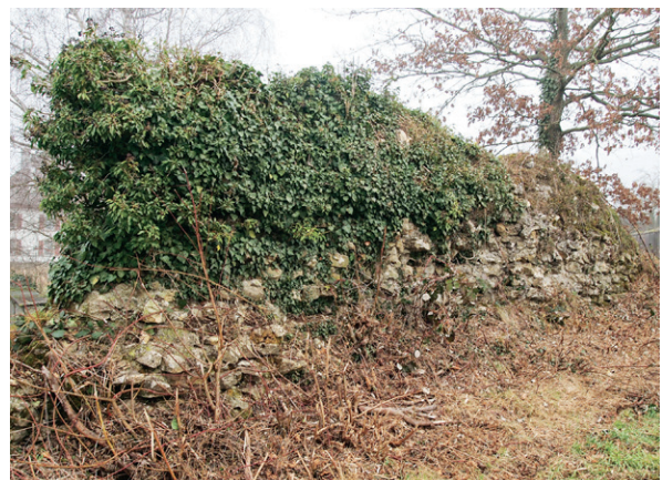
665 Teilstück T6–T7_M1. Erhaltenes Kernmauerwerk, welches im oberen Teil vollständig mit Efeu überwachsen ist.
