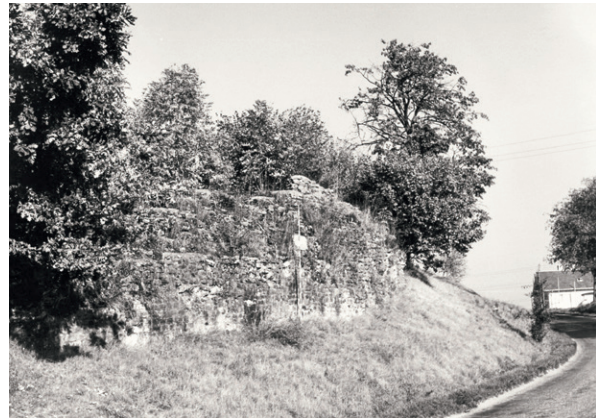
910 Bereich von «La Vignette B», Aussenseite der Kurtine gegenüber von T44 mit dem 1907 restaurierten Mauerwerk. Zustand im Jahre 1962.
