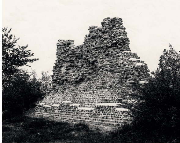
915 Teilstück T45–T46_M1, Bereich «La Vignette A». Zustand des Mauerwerks an der Aussenseite der Kurtine nach Abschluss der Restaurierungen der APA (1904).
