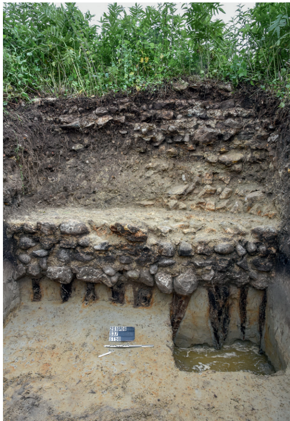
781 Teilstück T20–T21_M1 (vgl. Abb. 779), Ansicht des nördlichen Mauerseite mit intakten Resten des gemauerten Fundamentes und dem darunter ansetzenden Pfahlrost (Ausgrabung 2016.06).
