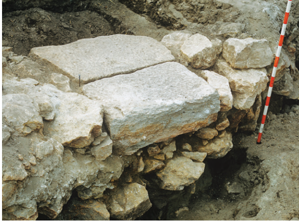
722 Zwei auf dem Mauerwerk der Kurtine aufliegende Muschel-sandsteinquader («Poterne des Mottes») (vgl. Abb. 721) (Ausgrabung 1961.01).
