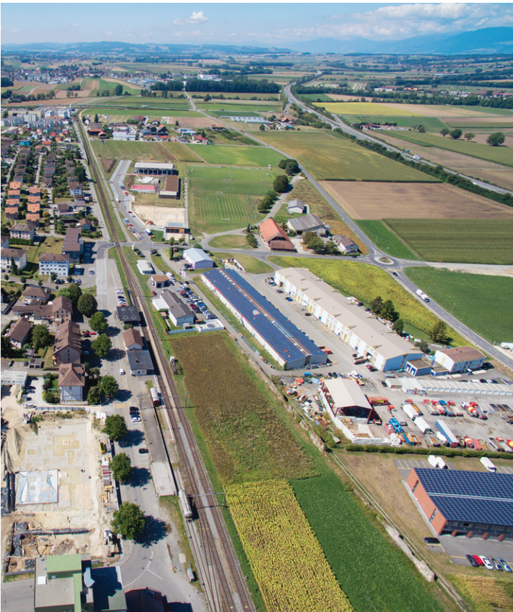
742 Blick aus Osten auf die westlichen Teile des Abschnittes T IV. Von der unteren, rechten Bildecke zieht die Kurtine (hier noch wenige Meter obertägig sichtbar) nach Westen, um oberhalb der Bildmitte die Bahnlinie zu queren. In der linken Bildhälfte (d. h. im Süden) ist das leicht gegen Süden ansteigende Terrain zu erkennen, während sich gegen Norden (rechts im Bild) die Ebene erstreckt (2018).
