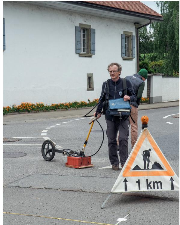
929 Georadar-Prospektion asphaltierter Strassenbeläge im Bereich der Kreuzung von Route d'Avenches/Route de Fribourg und Route de Villarepos (Prospektion 2016.08).
