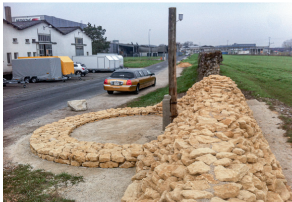
731 Blick von Osten auf den rekonstruierten Grundriss von T9. Im Zusammenhang mit der Überdeckung des original-antiken Mauerwerks der Kurtine durch ein Trockenmauerwerk (rechts im Bild) wurde der Turmgrundriss mit einer zweilagigen, trocken gesetzten Steinkonstruktion markiert. Im Inneren des Turmgrundrisses steht noch immer der 1922 angebracht Markierungspfahl (Zustand 2019).
