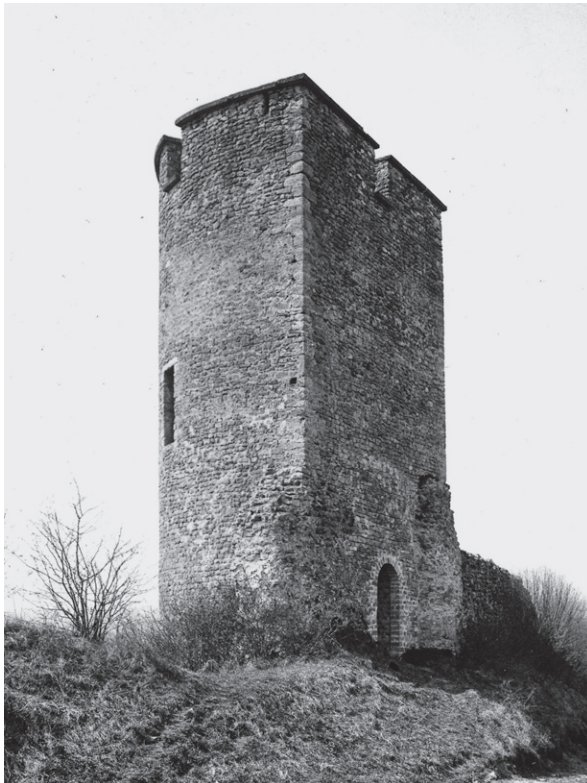
653 Blick auf die Ostwand von T2 (T2_M4) aus Südwesten. Zusatz vor den Restaurierungen des frühen 20. Jh. (ca. 1898).
