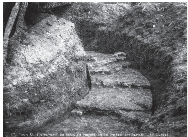
690 Westlicher Teil der Turmmauer T6_M1. Innerhalb des Mauerwerks ist das Fragment einer Muschelsandsteinplatte zu sehen, bei der es sich mutmasslich um ein Fragment einer Türschwelle handelt (25.1.1921).
