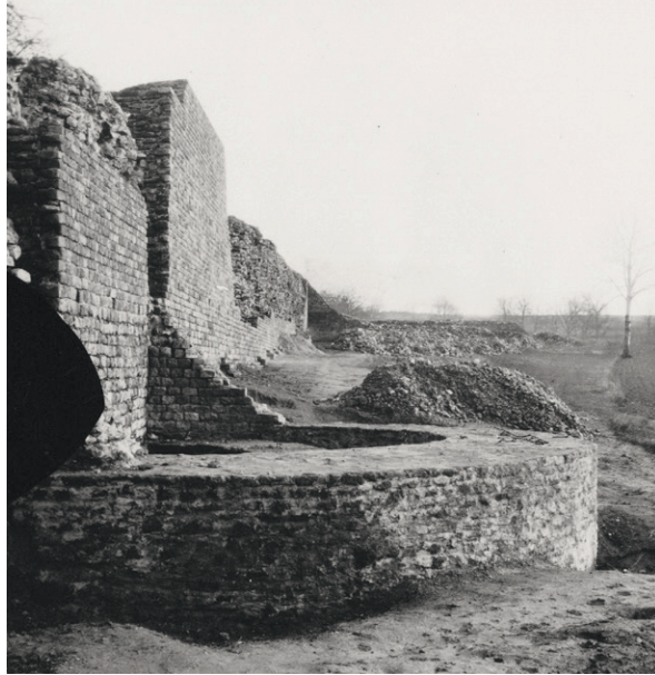
632 Blick auf die freigelegten und restaurierten Mauern von T1. Im Hintergrund ist das gegen Süden zum Osttor hin leicht ansteigende Gelände mit der teilweise restaurierten Kurtine sichtbar (16.12.1907).
