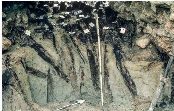
710 Detail des Eichenpfahlrostes. Gewisse Pfähle stecken schräg im sandig-torfigen Untergrund (Ausgrabung 1982.01).
