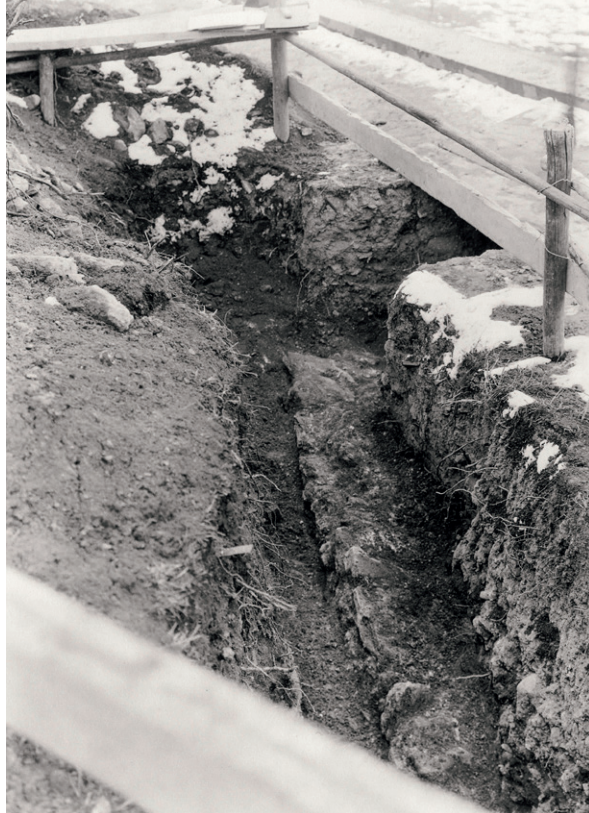
848 Teilstück T32-PO_M1, Aussenseite der Kurtine im Bereich der Fundament-OK (?) (22.1.1929).
