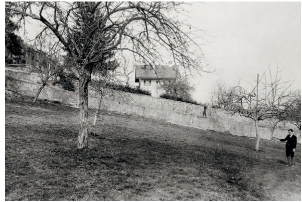
847 Teilstück T32-PO_M1 aus Westen. Auf der Kurtine verläuft der Chemin du Montmezard (4.9.1929).
