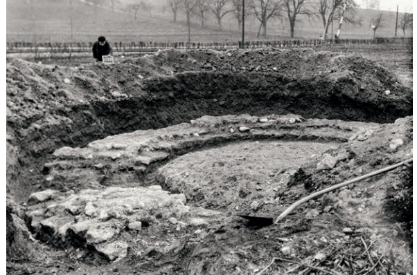
805 T22 mit Resten des mutmasslich originalen Turmbodens aus Kalkmörtel und Kalksteinsplittern (27.2.1926).
