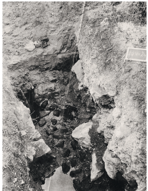
718 Aufschluss am Teilstück T12-T13_M1 (vgl. Abb. 717) mit dem im Grundwasserbereich stehenden Pfahlrost (20.8.1924).
