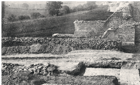
635 Blick auf den zentralen Teil des Torgebäudes des Osttors. Oberhalb der Bildmitte ist PE_M3 mit der runden Einbuchtung zu erkennen. Zu restauratorischen Zwecken wurde die Mauerkrone mit einer Schüttung aus losen Bruchsteinen versehen (1917).
