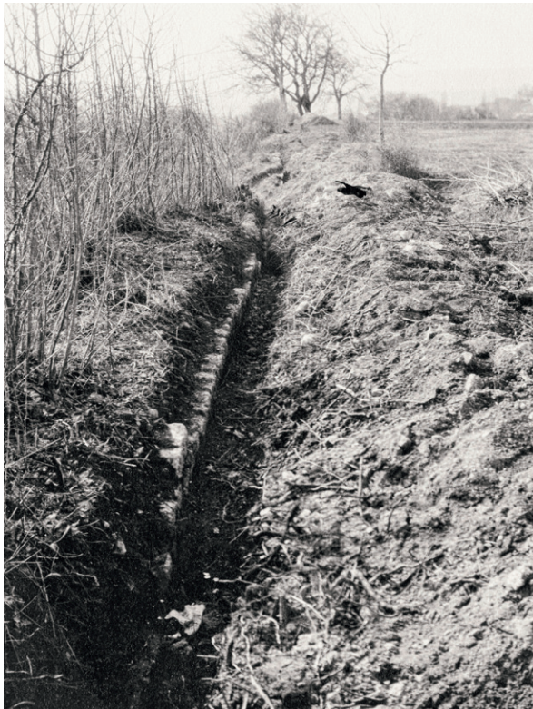
900 Teilstück T41–T42, Mauerinnenseite mit den obersten Lagen an erhaltener Mauerschale. Der Mauerkern reicht hier nur wenige Steinlagen höher (1929).
