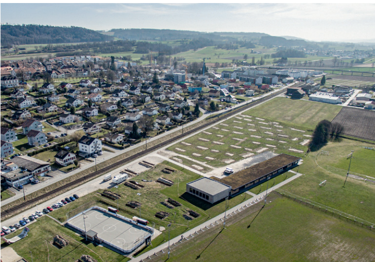
817 Aktuelles Luftbild des Westendes des Avencher Altstadtügels. Die moderne Überbauung hat die ursprünglich Topographie stark überprägt. Südlich der Bahnlinie ist weiterhin die mit Abschnitt T V fluchtgleiche Route de Sous-Ville erkennbar. Nördlich der Bahnlinie sind die Sondierschnitte der Ausgrabung Avenches – Zone sportive 2017.03 als helle Streifen ersichtlich (2017).
