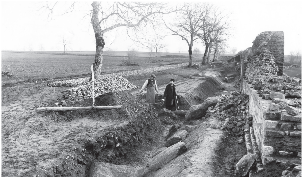
613 Ausgrabungsarbeiten im Bereich des Spitzgrabens. Architekturelemente aus Muschelsandstein in der Grabenverfüllung. Am rechten Bildrand Teile der konsolidierten und wiederaufgemauerten, landseitigen Kurtinenschale. In der Bildmitte ist A. Naef mit schwarzem Mantel zu sehen (L. Dupertuis, 16.12.1907).
