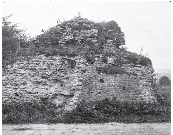
647 Westhälfte der abgerundeten Innenseite von PE_M12. Im opus vittatum des Sichtmauerwerks sind mehrere Löcher zu sehen, die vermutlich mit einem turminternen Treppenaufgang zu erklären sind. Im Hintergrund setzt der deutlich höher erhaltene Mauerkerne der Kurtine an (1897).
