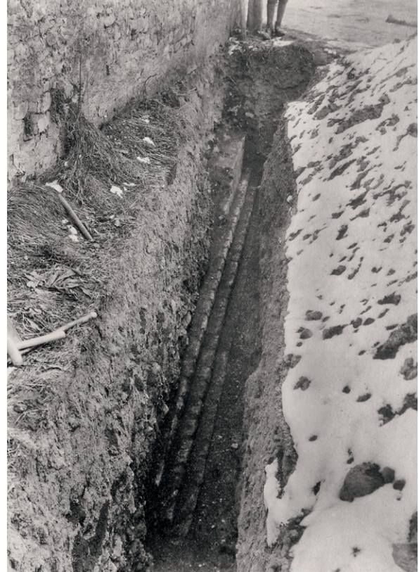
849 Teilstück T32-PO_M1, Innenseite der Kurtine mit erhaltenem, abgetrepptem Fundamentvorsprung. In der linken, oberen Bildecke ist der Ansatz des Chemin du Montmezard zu sehen (22.1.1929).
