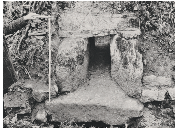
746 Stadtseitiger Abschluss des Durchlasses «aqueduc 1» (20.8.1924).
