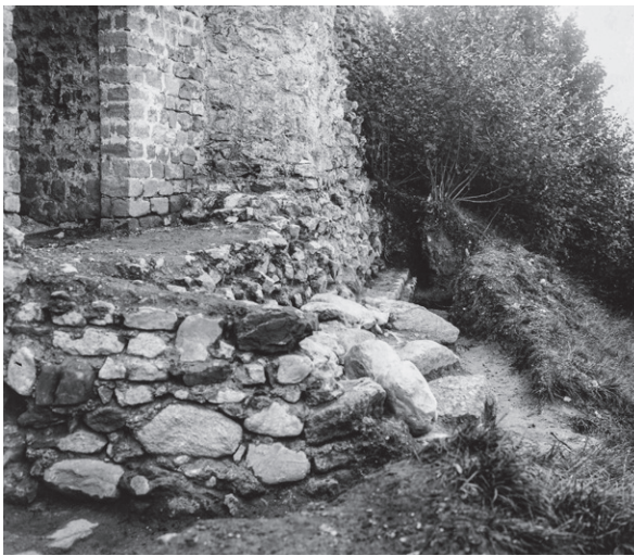
655 Südlicher Abschluss des halbrunden Mauerfundamentes T2_M6, welches östlich an T2 angebaut wurde. Die heterogene Zusammensetzung des Mauerwerks ist deutlich zu sehen (1905–1906).
