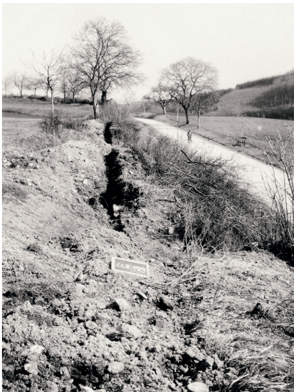
901 Teilstück T42–T43, Sondiergraben an der Innenseite der Kurtine. Rechts im Bild der Vorläufer der heutigen Route de Donatyre (26.3.1929).
