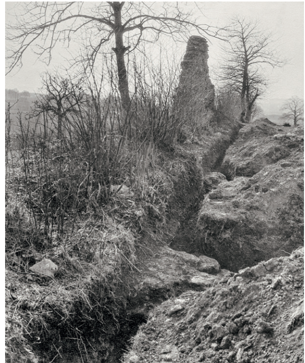
919 Ausgrabung an der Kurtine (Teilstück T45–T46), unmittelbar östlich des Bereiches von «La Vignette A» (Hintergrund). Im Vordergrund ist der westliche Ansatz der Turmmauer T46_M1 an der Kurtine zu sehen (8.3.1930).
