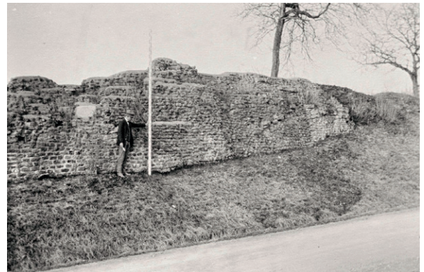
902 Landseitige Ansicht der Kurtine am südöstlichen Ende des Teilstückes T43–T44 (gegenüber von T44). Dieser Bereich wurde 1907 unter der Bezeichnung «La Vignette B» restauriert (1929).
