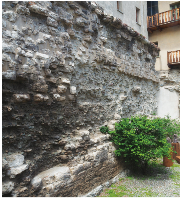
620 Stadtmauer von Aosta. Aussenseite der Kurtine südlich der Porta Praetoria. An der OK der Kurtine sind die gegen aussen vorragenden Abdeckplatten des Wehrgangs in rund 5 m Höhe erhalten.
