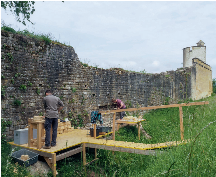
624 Restaurierungsarbeiten an der Aussenseite der Kurtine (Teilstück T1–T2_M1). Schadhafte Handquader werden ausgetauscht und offene Fugen neu ausgefugt (2018).
