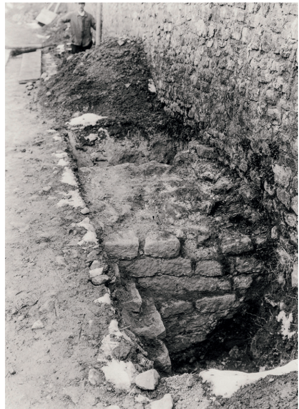
855 Aussenseite der Turmmauer T32_M1 mit regelmässigem Handquadermauerwerk. Links und rechts der Mauer setzten neuzeitlich-moderne Mauerstrukturen an (22.1.1929).
