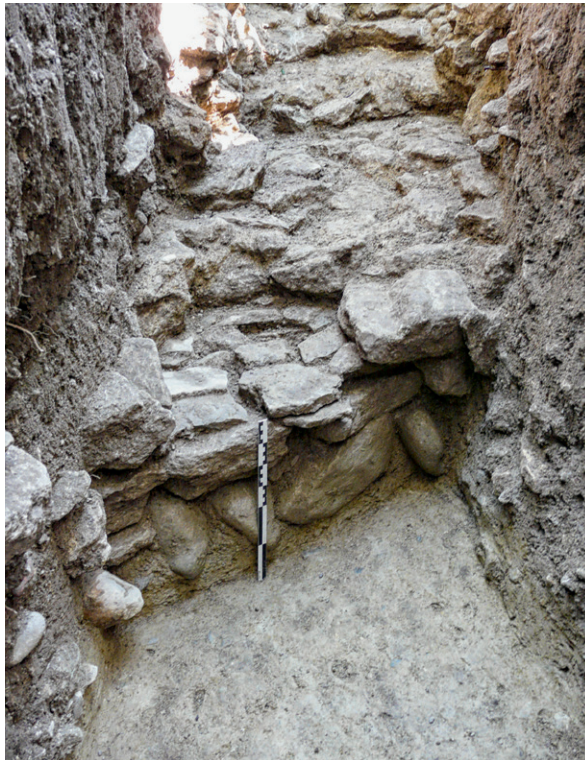
830 Blick auf die Aussenseite der Fundament-UK mit einer trocken gesetzten Gerölllage und gemörteltem Mauerwerk aus Muschelsandsteinen (Ausgrabung 2011.07).
