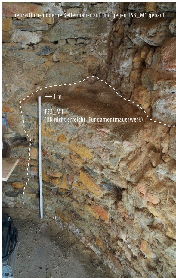
933 Rund verlaufendes Mauerwerk aus Neuenburger Kalkstein und Muschelsandstein im Bereich des Kellers der Parzelle Nr. 1108. Mutmasslicher Rest der Turmmauer T53_M1 (2016).
