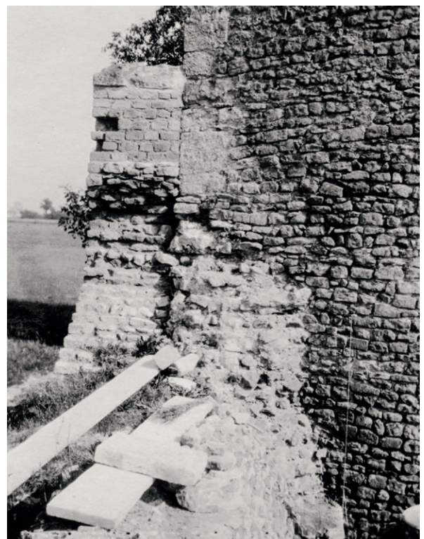
669 Detailfoto des erhaltenen Ansatzes des Kurtinenmauerwerks an der Nordseite von T2 (20.9.1927).
