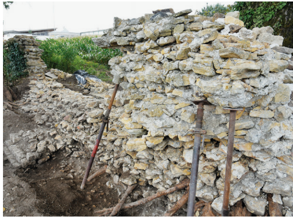
749 Teilstück PN–T17_M1 (Aussenseite) mit Kernmauerwerk und einem kurzen Abschnitt erhaltener Mauerchale im Bereich des Fundamentvorsprungs (unten links) (Restaurierung 2015.06).
