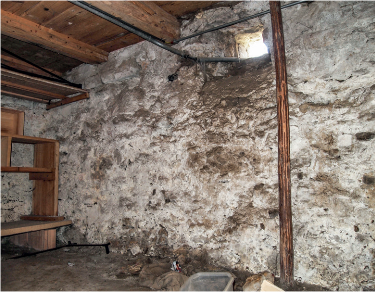
941 Südliche Kellerwand mit über 2 m hoch erhaltenem Fundamentmauerwerk der Kurtine (2016).
