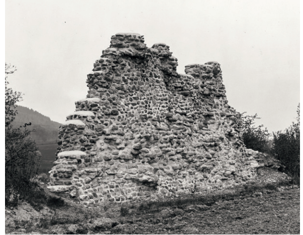
916 Teilstück T45–T46_M1, Bereich von «La Vignette A». Innenseite der Kurtine nach Abschluss der Restaurierungen (1904).
