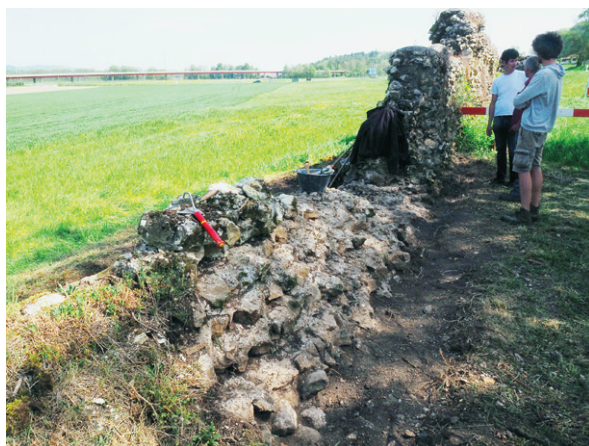
704 Freigelegte und gereinigtes Kernmauerwerk der Kurtine (Teilstück T8–T9_M1), im Hintergrund die zwischen 1898 und 1902 restaurierten Mauerpartien (2018). Vgl. Abb. 61–62.
