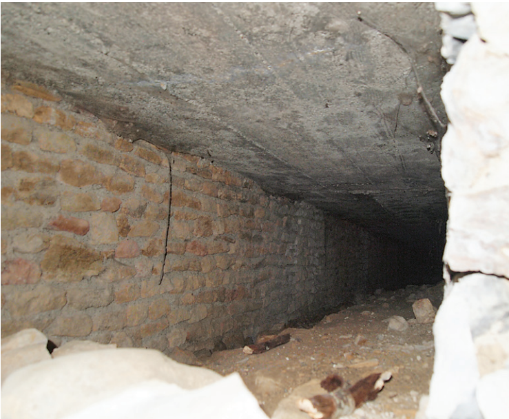
604 Blick in den Hohlraum des nach «System Siegart» rekonstruierten Mauerwerks auf dem Teilstück PE-T73_M1. Am oberen Bildrand ist die Untersicht der Abdeckplatte aus Beton zu sehen (13.4.2016).
