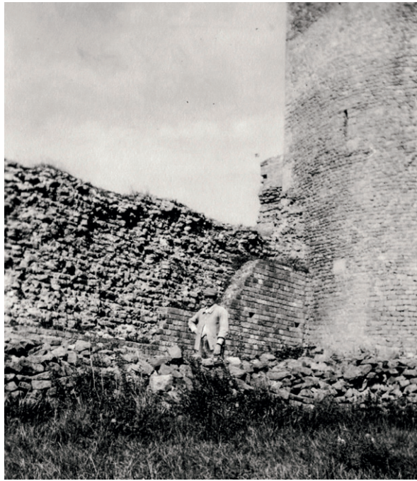
667 Kurine nördlich von T2 (T2–T3_M1) mit dem bis in eine Höhe von 5.46 m hoch erhaltenen Mauerkern. Im unteren Bereich der Kurtine wurden Teile der inneren Mauerschale bereits restauriert (12.8.1927).
