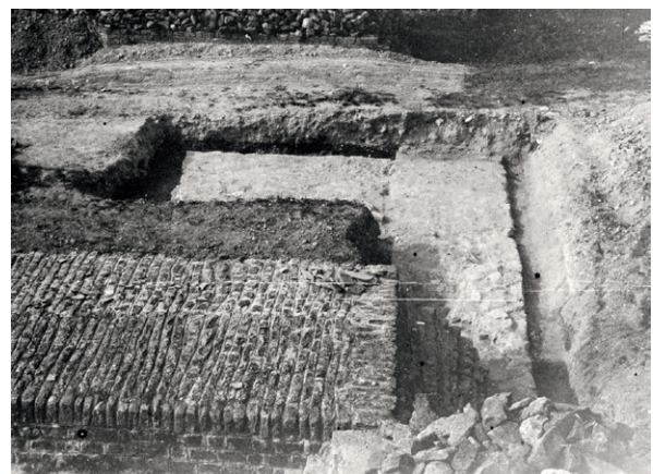
639 Blick von Süden auf den oberflächlich freigelegten Pfeiler PE_M5, der im Osten mit deutlicher Fuge an PE_M10 anstösst. Im Vordergrund PE_M6 (1917).
