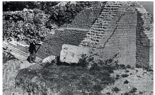
633 Östlicher Abschluss von PE_M1. Teile der originalen, südlichen Mauerchale in opus vittatum und oberhalb der farblichen Markierung restauriertes Mauerwerk (1898).
