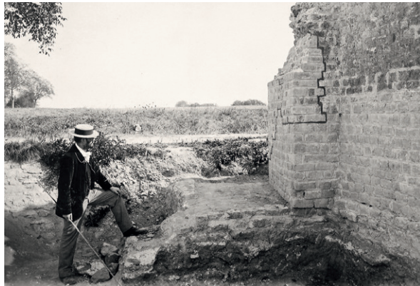
644 Bereich des Eingangs in den südlichen Torturm (PE_M12). Die westliche Fassadenmauer PE_M10 ist hier als Mörtelbett zu einer Schwellenunterlage ausgebildet (1898).
