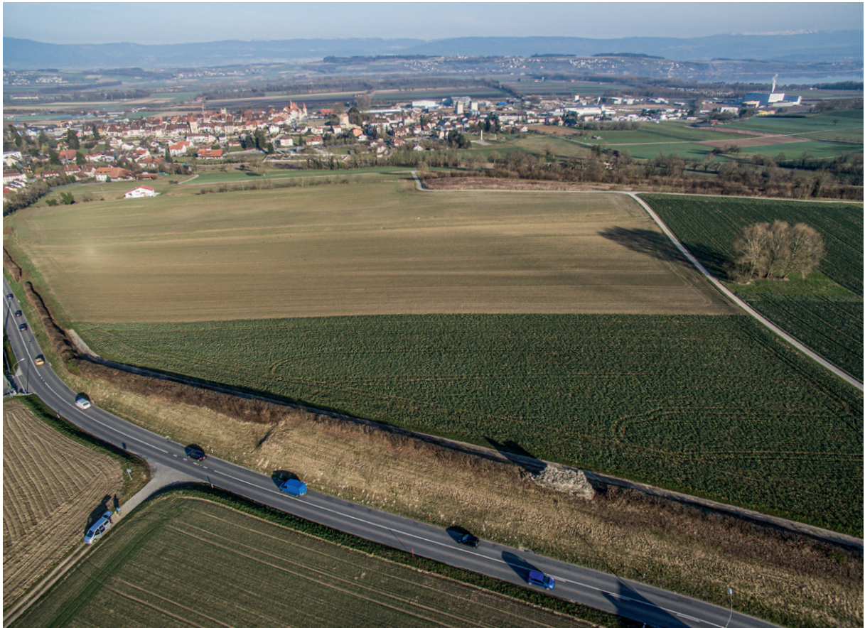
912 Blick auf den Westteil des Abschnittes T VIII mit dem markanten, bis in 5 m Höhe erhaltenen Bereich von «La Vignette A» (T45–T46_M1). Hier wird deutlich sichtbar, dass das Terrain intra muros leicht in eine West-Ost verlaufende Mulde abfällt, um rund 400 m weiter nördlich (oberhalb der Bildmitte) wieder anzusteigen (2016).
