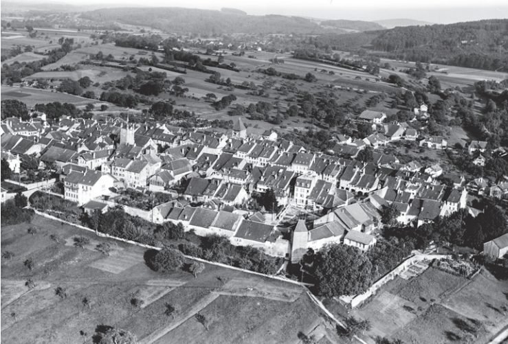
823 Westteil der mittelalterlichen Altstadt von Avenches mit dem nördlich und westlich stark abfallenden Hügelzug. Im Bereich der neuzeitlich-modernen Terrassenmauer, rechts vorne verläuft die Kurtine des Abschnittes T VI (Teilstück T29–T30_M1) (1919).
