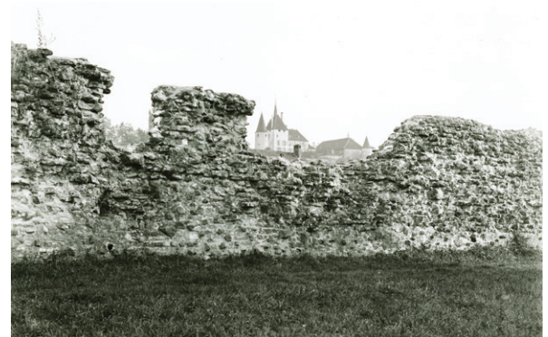
743 Landseitige Ansicht des 1893 restaurierten Teilstückes T20–T21_M1. Im Hintergrund ist das mittelalterliche Schloss von Avenches zu sehen (F. Boissonas, 1914).
