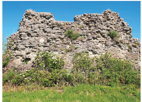
917 Aktuelle Situation der Kurtinaussenseite im Bereich von «La Vignette A». Die links der Bildmitte zu sehende Zementplakette bezeichnet mit «R 1904» das Jahr der Restaurierung (2018).
