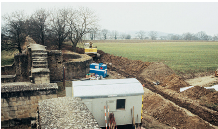
616 Leitungsgraben unmittelbar östlich ausserhalb des Osttores (Ausgrabung 1991.08, Schnitt 9, vgl. Abb. 608).
