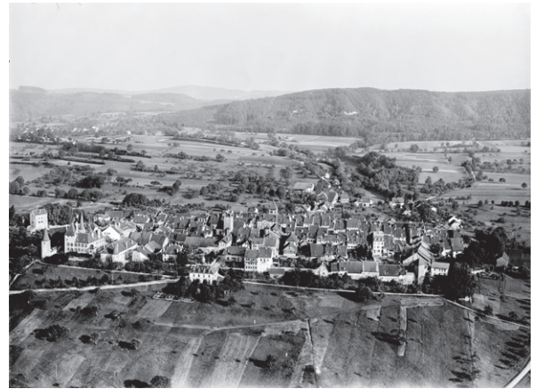
816 Westlicher Abschluss des Altstadtügels von Avenches. Der Verlauf des Abschnittes T V eng entlang der westlichen Plateaukante ist lediglich zu erahnen. Südlich des Altstadtügels setzt sich die Stadtmauer entlang der Route de Donatyre gegen Süden und Südosten fort (1919).
