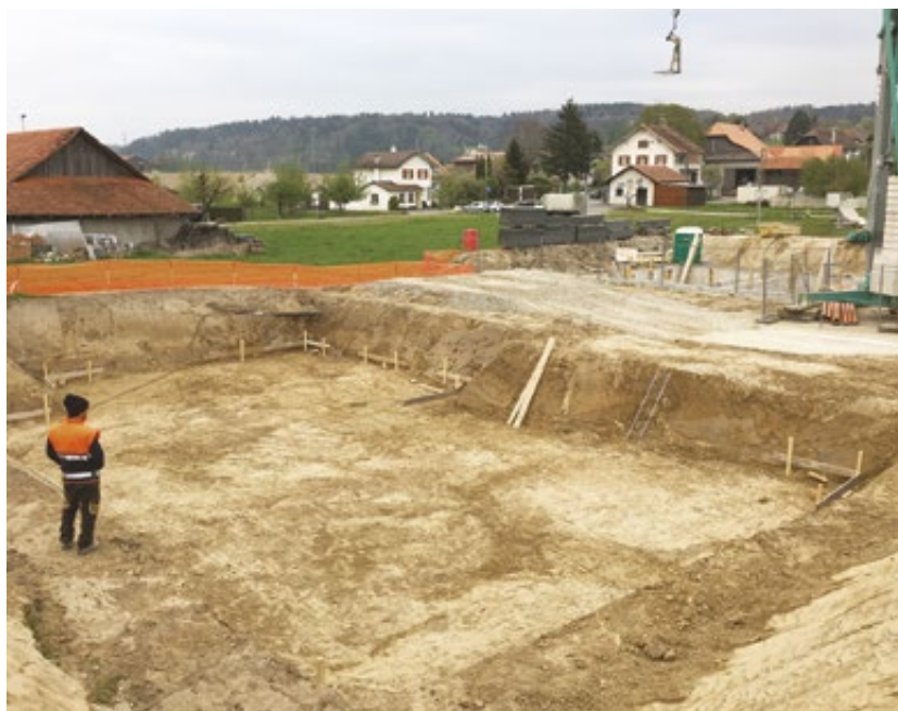
Fig. 54 2017.05. Donatyre, Chemin des Hôteaux. Les terrassements de la parcelle voisine (n° 5812) n'ont pas pu être suivis par les archéologues du SMRA.
