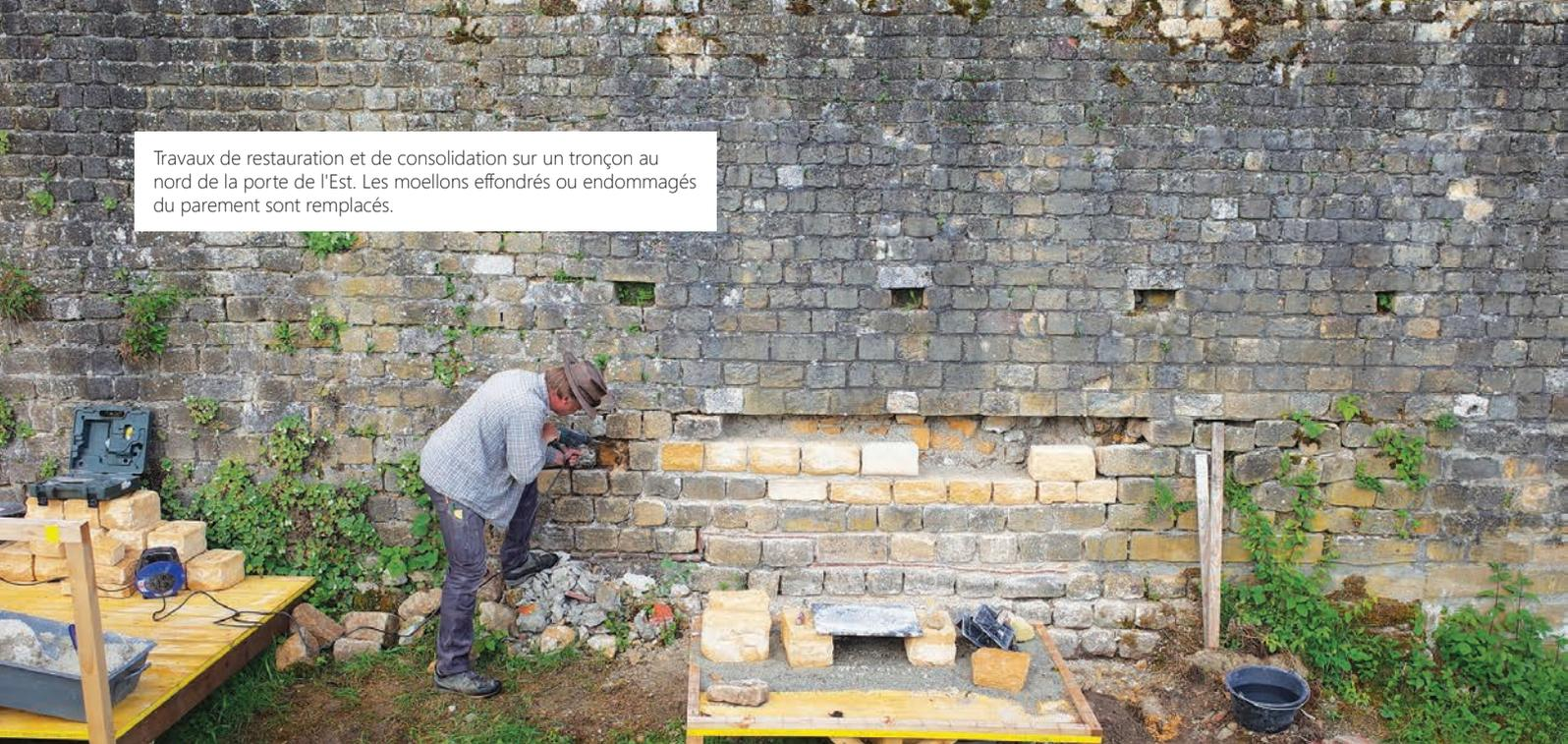
ration global pour l'enceinte romaine et développé notamment de nouveaux mortiers adaptés aux différentes situations sur le terrain. Afin de préserver les maçonneries originelles, l'équipe de restauration doit parfois démonter les parements modernes désolidarisés et les remonter en utilisant un nouveau mortier plus approprié. Une opération longue et délicate qui permet à la fois de consolider les maçonneries et d'en maintenir l'aspect homogène.
