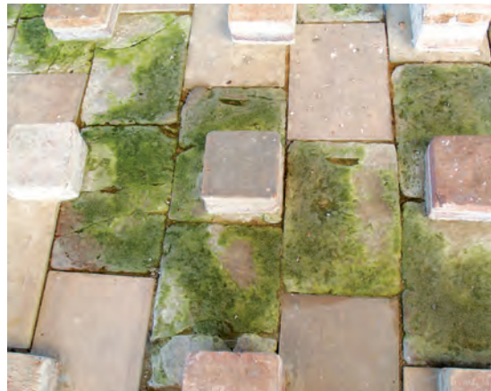
Fig. 29 – Thermes de Perruet. Détail du revêtement de sol dans la salle chauffée (tepidarium). Les dalles originales sont imprégnées d'humidité en raison du niveau élevé de la nappe phréatique et sont colonisées par les algues
