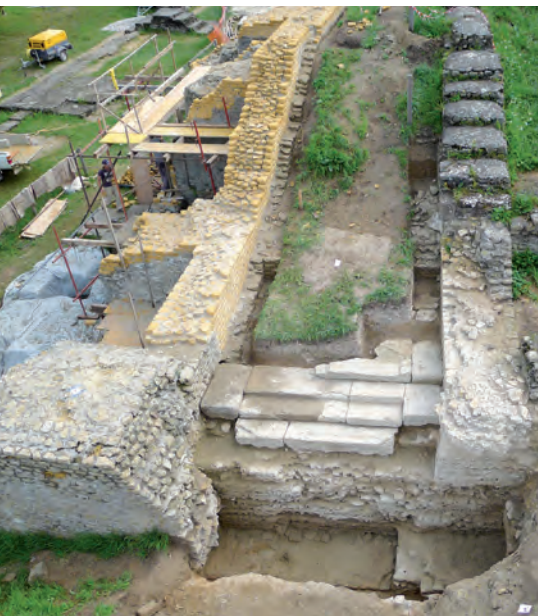
Fig. 35 – Quelques-unes des marches d'un escalier d'accès aux gradins du théâtre ont été dégagées lors des travaux de restauration du monument
