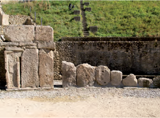
Fig. 30 – Amphithéâtre. Mur nord du couloir ceinturant l'arène au sud, constitué de grandes plaques de grès coquillier dressées verticalement (orthostates)
