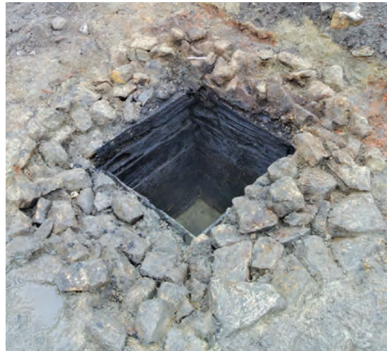
Fig. 37 – Cuvelage en bois de chêne daté de 250/251 ap. J.-C. d'un puits de l'insula 15
