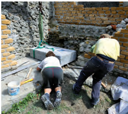
Fig. 24 – Théâtre. Des tailleurs de pierre sont à l'œuvre sur un bloc de grès coquillier dans la halle d'entrée sud-ouest
