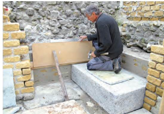
Fig. 25 – Théâtre. Halle d'entrée sud-ouest. Edouard Rubin coffre la chape de mortier sur laquelle seront visibles les négatifs de blocs au-dessus du nouveau bloc mis en place
