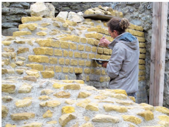
Fig. 22 – Théâtre. Consolidation des structures maçonnées existantes et jointoyage des murs restaurés
