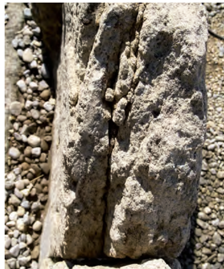
Fig. 31 – Amphithéâtre. Vue de détail d'une dalle verticale en place (orthostate). Les strates verticales de la pierre se sont désolidarisées et les fissures permettent à l'eau de s'infiltrer dans la roche
