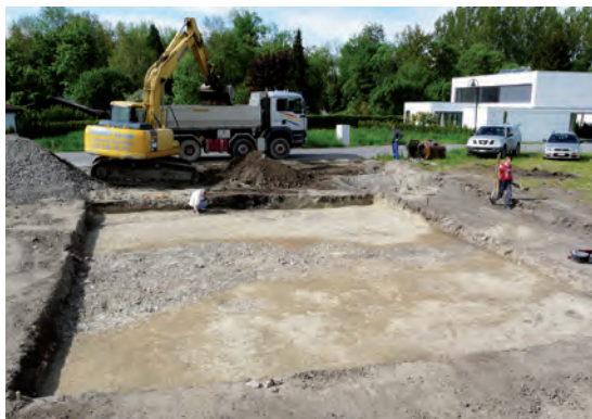
Fig. 34 – Fouilles en cours sur l'une des parcelles investiguées en 2013 au lieu-dit Pâquier-aux-Oies, commune de Faoug
