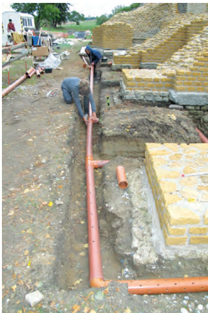
Fig. 26 – Théâtre. Mise en place des conduites de drainage au pied des maçonneries. De façon à ne pas totalement perturber de potentielles relations stratigraphiques, les tranchées sont creusées à 40 cm des maçonneries
