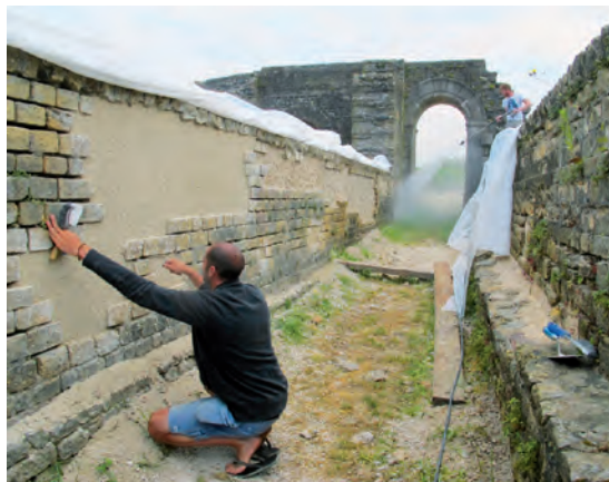
Fig. 27 – Porte de l'Est. Consolidation provisoire des grandes lacunes dans les parements des murs au moyen d'un mortier de chaux spécialement développé pour cet usage
