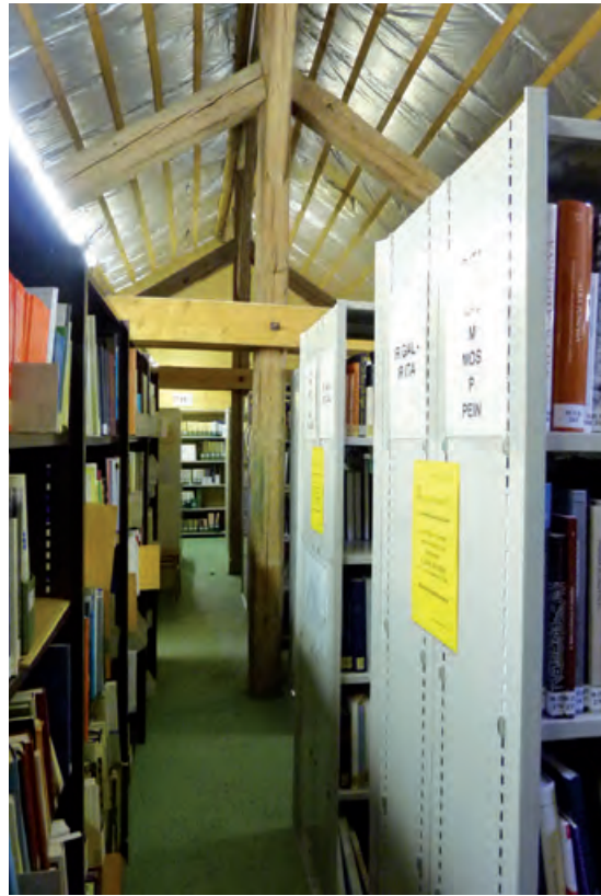
Fig. 6 – Le magasin principal de la bibliothèque du SMRA au dernier étage de l'avenue Jomini 16
