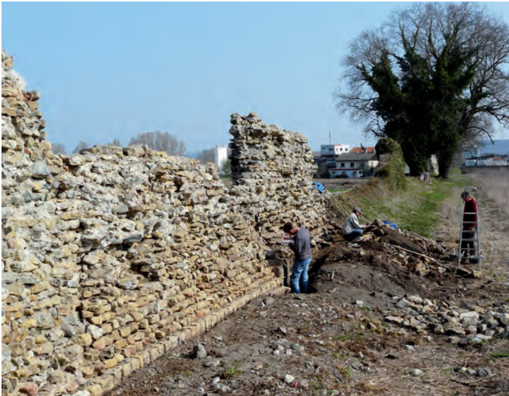
Fig. 25 – Relevé d'une portion du mur d'enceinte en cours de restauration
