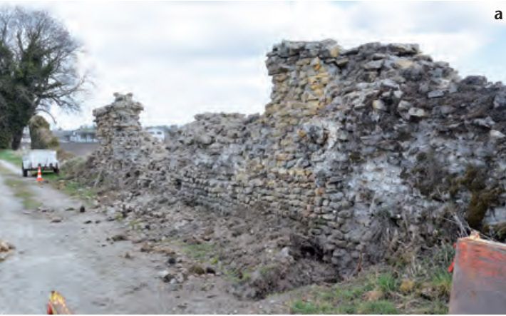
Fig. 14 – Mur d'enceinte, tronçon le long du chemin de Derrière les Murs. Vue avant (a) et après (b) les travaux de consolidation. Conduit d'évacuation des eaux (parement interne) avant (c) et après (d) les travaux
