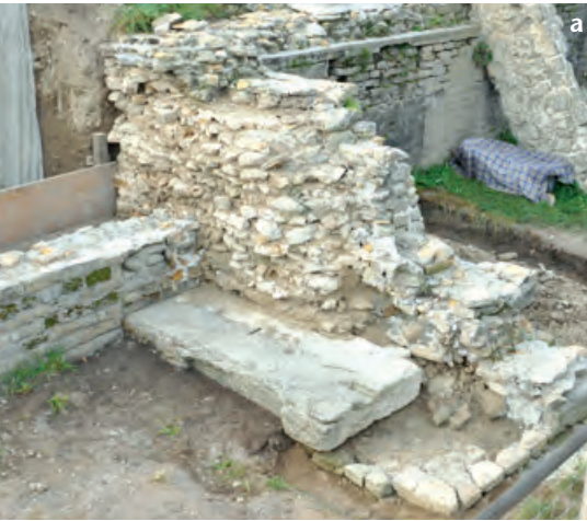
Fig. 13 – Théâtre. a : vue d'un noyau de maçonnerie romaine avant restauration (dérestauration partielle des éléments du 19 e siècle). b : restitution du négatif des blocs manquants (en cours de réalisation). Plan de situation ci-dessous
