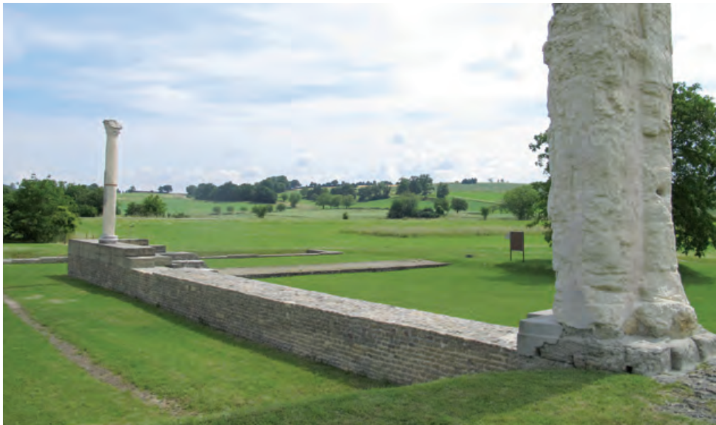
Fig. 11 – Temple du Cigognier, vue d'ensemble de la partie du portique restauré en 2012
