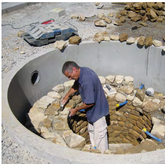
Fig. 12 – La restauration du puits de la place de l'Église a été confiée à Édouard Rubin
