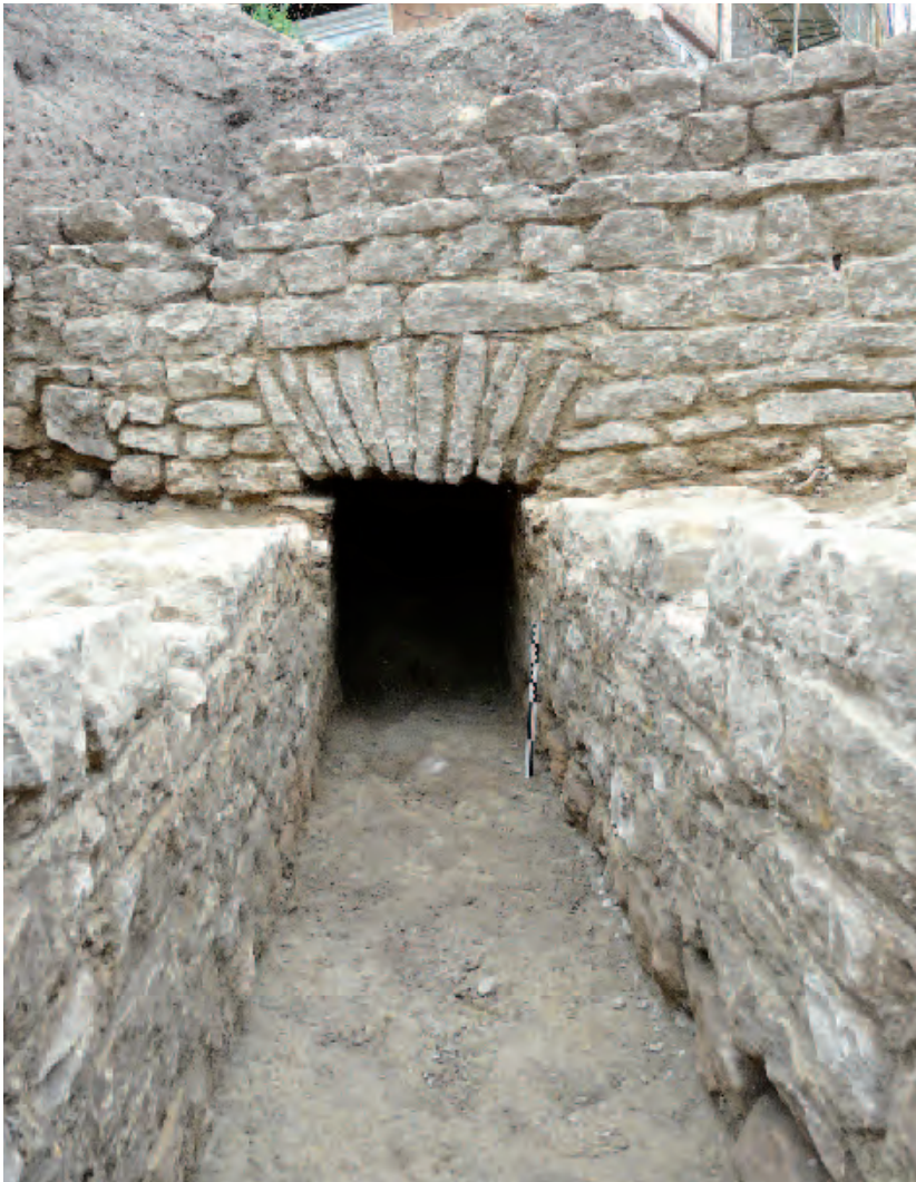
Fig. 37 (ci-dessus) 2011.04. Insula 7 / palais de Derrière la Tour. Parement sud du mur M 3 vu depuis le conduit St 10. La voûte est constituée d'étroites dalles de calcaire jaune. Des encoches pour l'installation des planches de couverture sont visibles entre la voûte et l'arase des murs de la canalisation.
