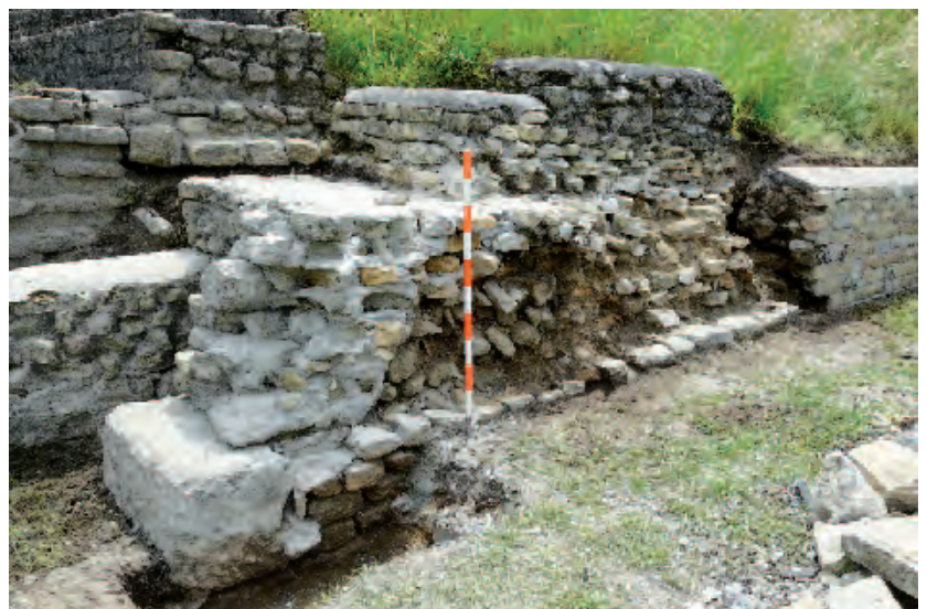
Fig. 31 2011.03. Théâtre. Vue du mur M 91 après effondrement des restaurations de 1900.
