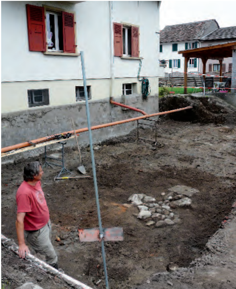
Fig. 60 2011.06. Route du Faubourg 18. Vue du chantier, avec, au centre, l'empierrement St 1.
