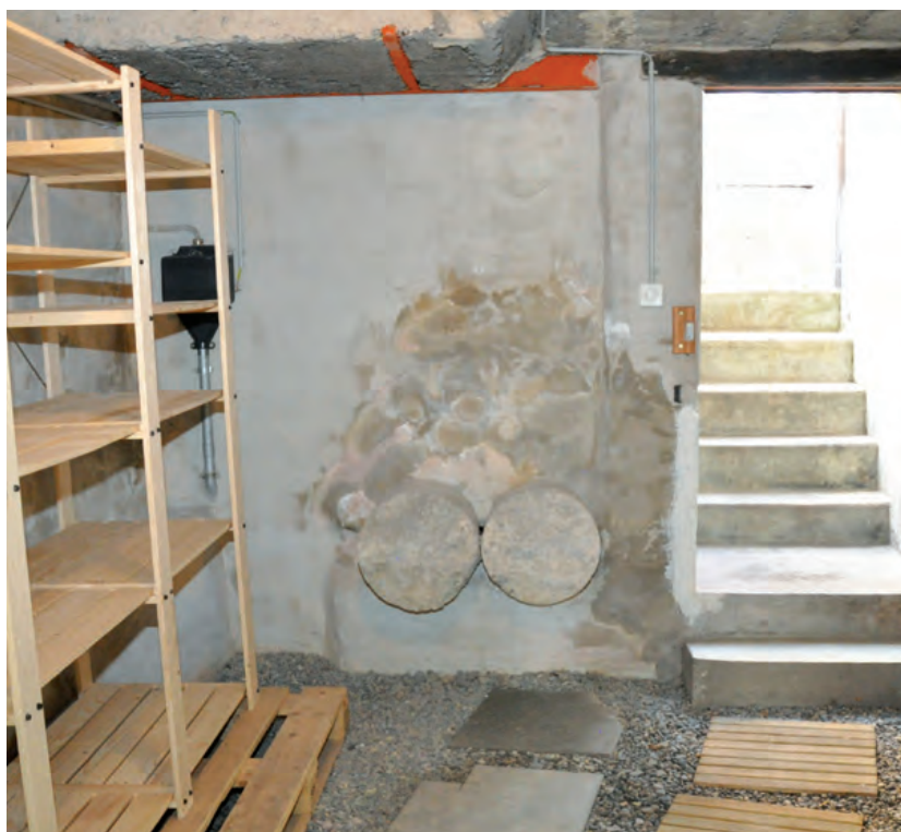
Fig. 62 (en haut à g.) 2012.06. Rue des Alpes 7. Au centre de l'image, les deux tronçons de fût de colonne encore scellés dans le mur de la cave.
