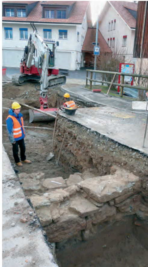
Fig. 7 2008.02. Route d'Oleyres. Vue de la canalisation.
