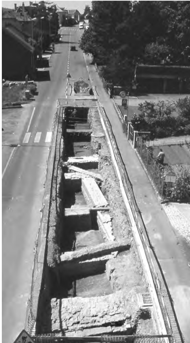
Vue d'une portion de la tranchée ouverte au bas de l'avenue Jomini. On distingue au premier plan les imposantes fondations du temple de la Grange des Dîmes
