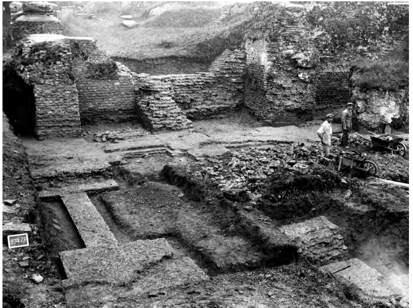
Vue des fondations dégagées en 1927 à l'angle nord-est du théâtre
