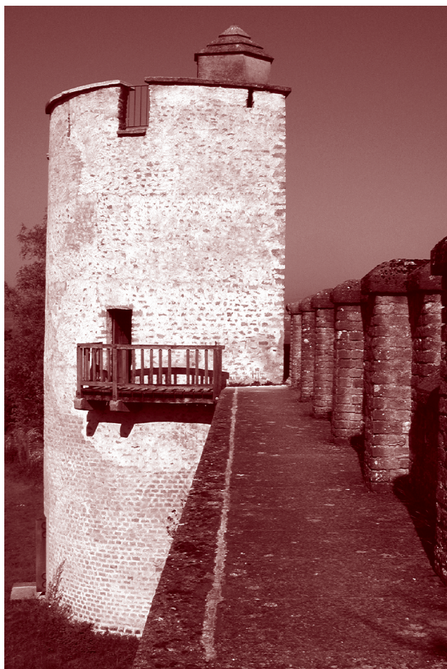
La dégradation de l'épiderme de la tour a nécessité une restauration complète de la façade. Après ce lifting qui aura duré près d'une année, voici la Tornallaz et l'accès au mur d'enceinte rendus au public.
