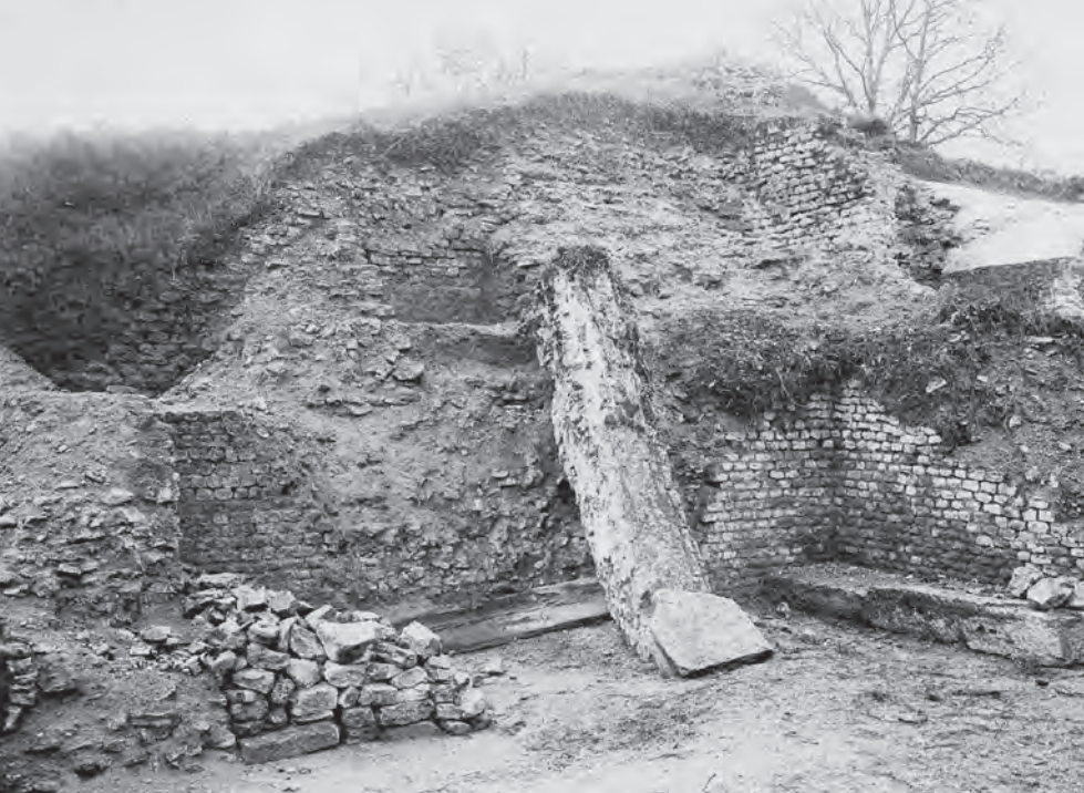
Zustand des Mauerwerks in der südwestlichen Eingangshalle vor Beginn der ersten Restaurierungen am Ende des 19. Jahrhunderts. Grosse Teile des Schalenmauerwerks sind systematisch abgebrochen worden
