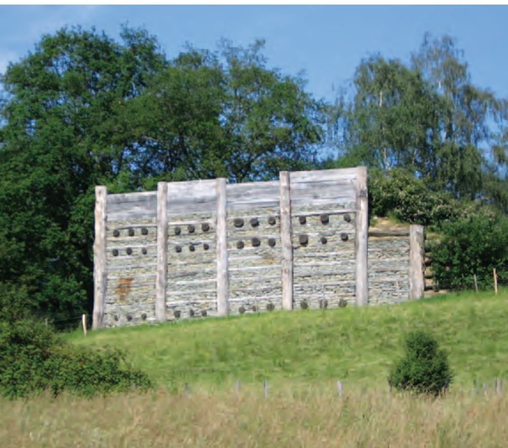
Reconstitution d'un tronçon du rempart gaulois du Mont Vully réalisée en 2002
