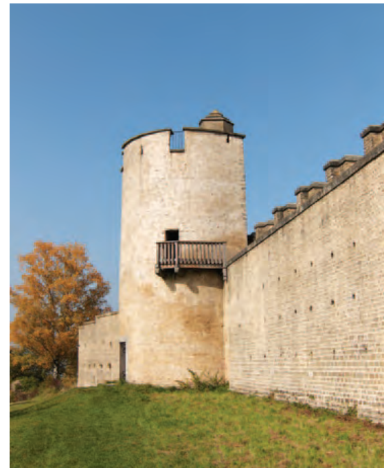
La Tornallaz et les courtines adjacentes, restaurées ces dix dernières années
