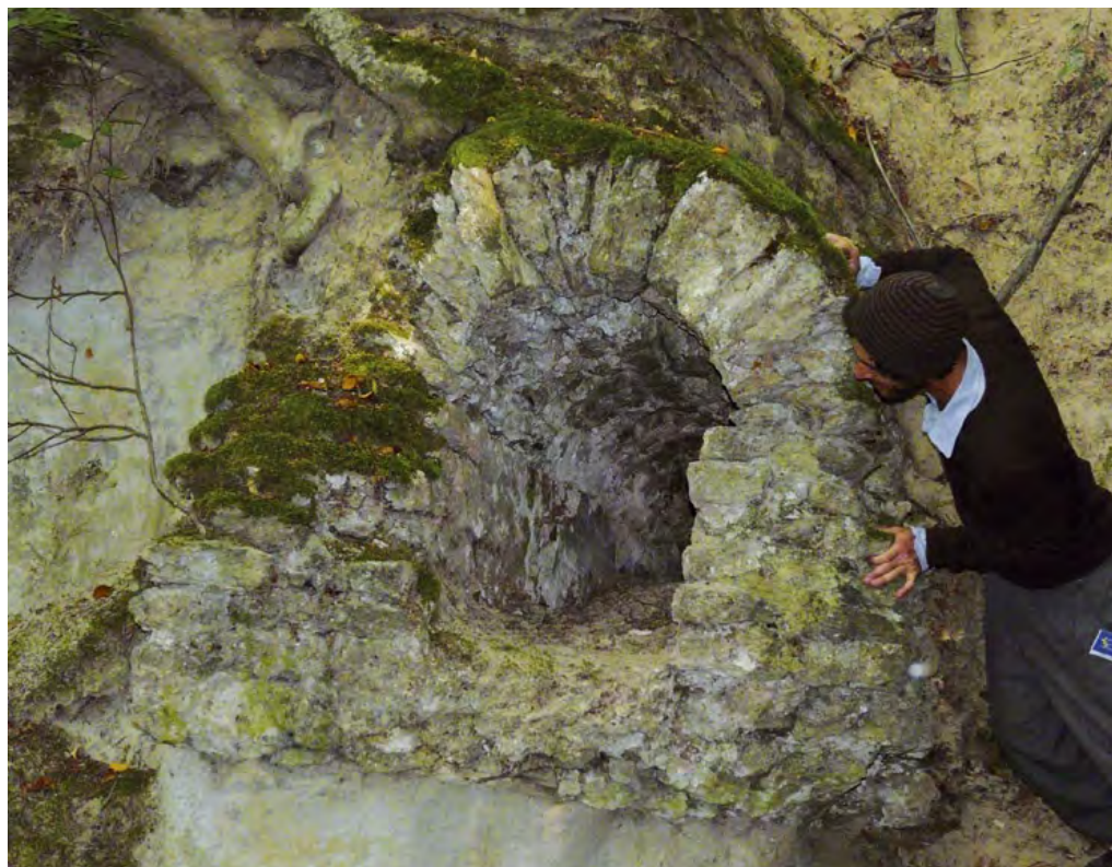
À gauche et ci-dessus, tronçon conservé de l'aqueduc de Coppet. La canalisation a été aménagée dans une tranchée creusée dans la molasse
