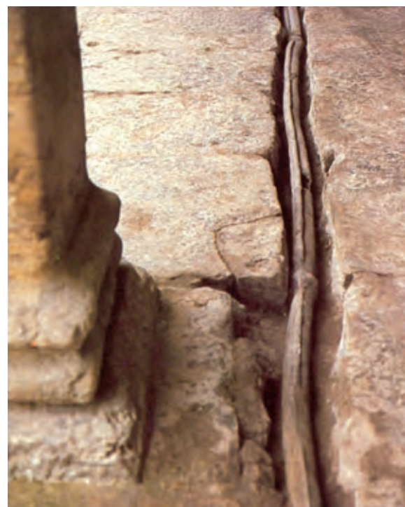
Canalisation en plomb aménagée dans le sol des thermes de Bath GB
