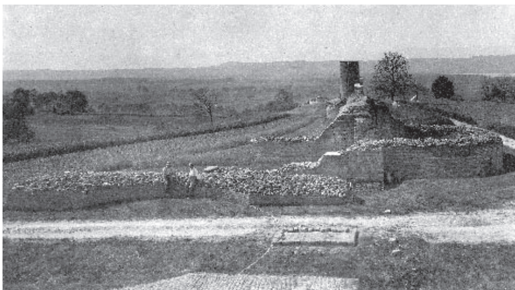
Philippe Bridel Vue de la porte de l'Est et de l'enceinte romaine en cours de restauration en 1921, par Fred Boissonnas
